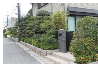
エクステリア、外構工事
