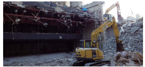
▲旧グランドオリオン 解体工事
