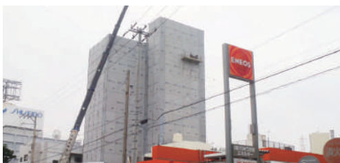
▲立体駐車場 解体工事
