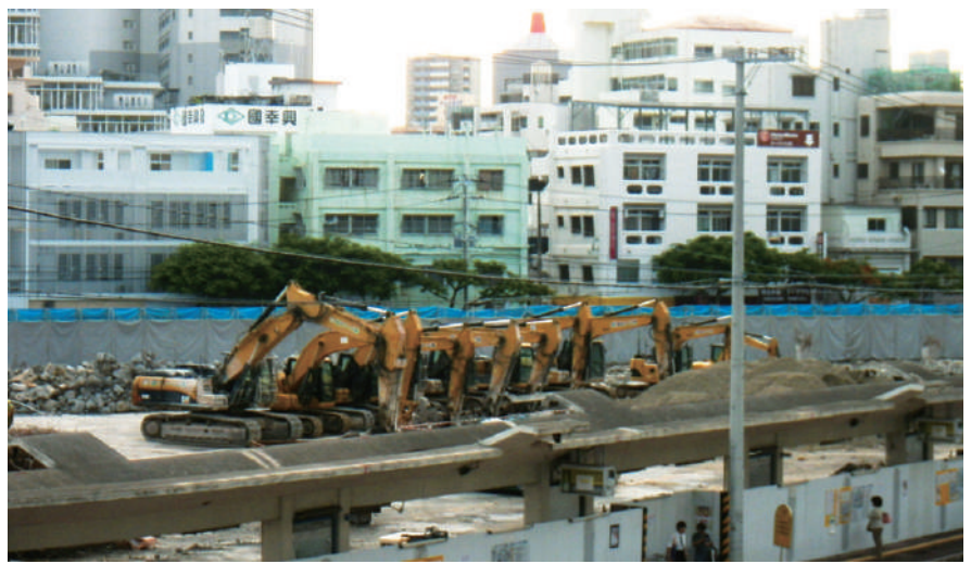
▲旧那覇バスターミナル 解体工事
