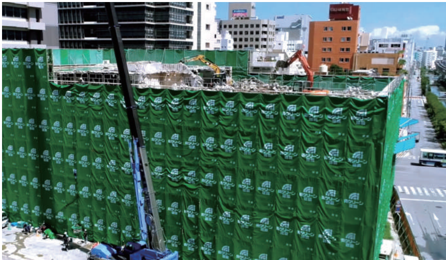
▲琉球銀行本店 解体工事
