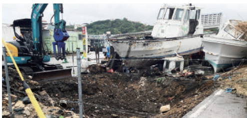
▲船舶解体工事
