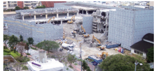
▲公共工事／那覇市本庁舎 解体工事
